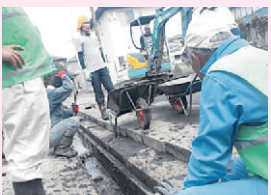
側溝の土砂搬出
