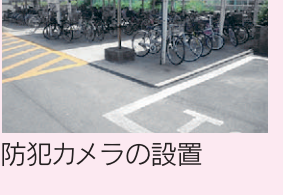
防犯カメラの設置
